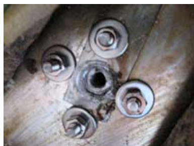
Bild 2: Ett hål ska gå rakt igenom det befintliga läsblecket.
