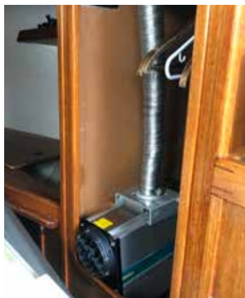
Bild 1. På bilden har jag tagit bort en av fästbultarna till värmaren. Monterar/demonterar den på mindre än fem minuter.
