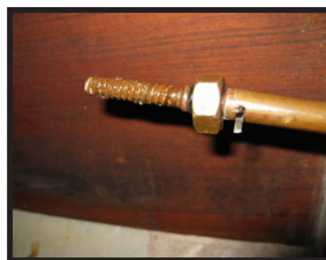
Fjärrmanövrering med saxsprint, mutter och ventilaxel påmonterad, färdig att skruvas ihop med ventilhuset.
