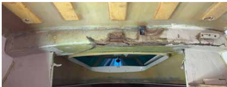
Mastbalken före bytet.
