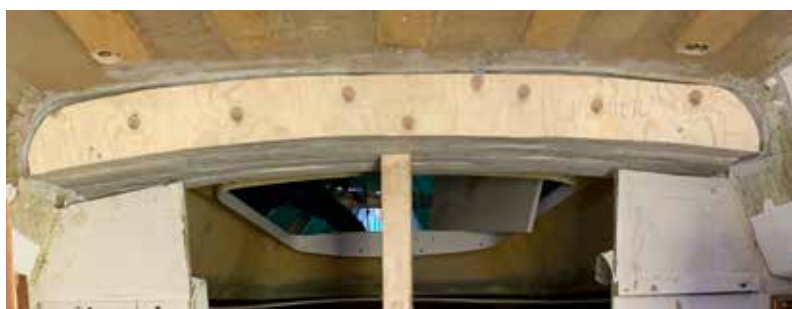
Ny mastbalk på plats.
