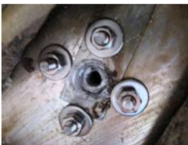
Bild 2: Ett hål ska gå rakt igenom det befintliga låsblecket.
